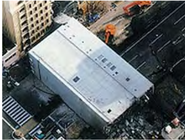
阪神・淡路大震災で倒壊したビル 出展:国土交通省資料
