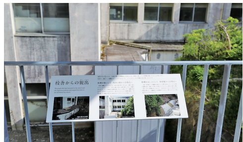
写真-3 震災遺構門脇小学校(本校舎と展示館)
