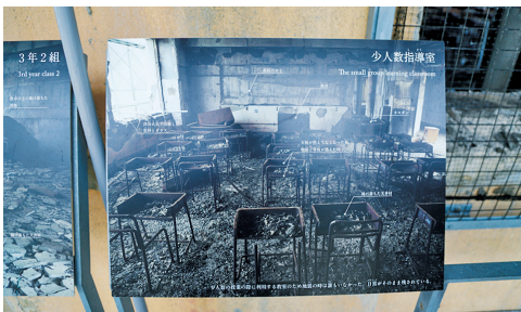
写真-2 震災遺構門脇小学校の内部(本校舎)
