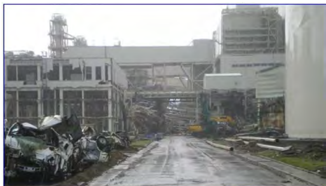
(d) Damages to unit #1.
