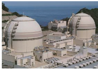
大飯原子力発電所3号機(左)と4号機(右)の耐性検査の様子。3号機は23日の臨時会議で、4号機は24日の臨時会議で実施された。
