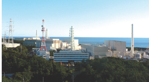
浜岡原子力発電所の全景
