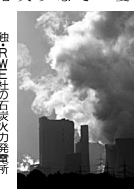
独・RWE社の石炭火力発電所
