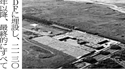
コーブランドに立地するドリッグ低レベル処分場
