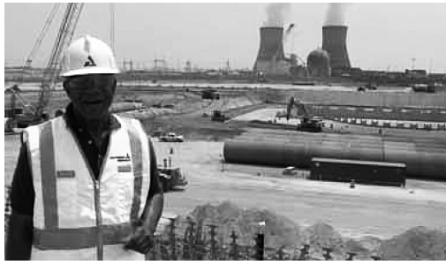
部分認可に従って準備作業が進められているボーグル建設サイト
