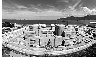
中国広東核電集団有限公司(CGNPC)は八日、同国で十四基目の原子炉の建設を開始した。
