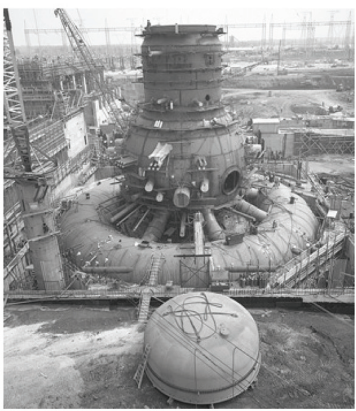
ゼネラル・エレクトリック社(GE)が手がけた最初の量産型の商業用原子炉マーク1。福島第一原発の1号機から5号機はすべてこのマーク1。
