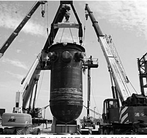
三門1号機の圧力容器設置作業 (© SNPTC)
