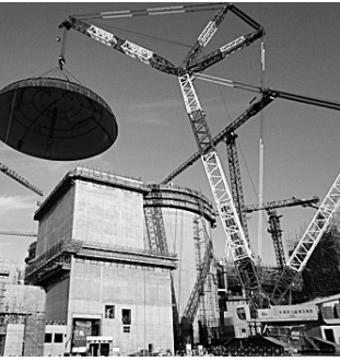
三門1号機の圧力容器設置作業 (© SNPTC)
