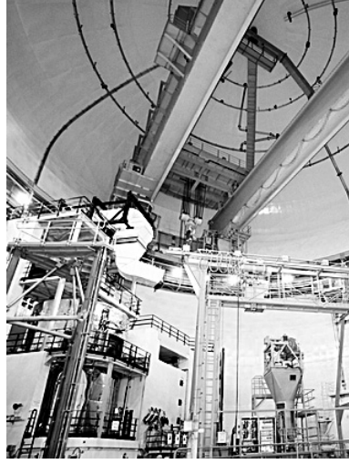
秦山II-4の燃料装荷作業(©CNNC)
