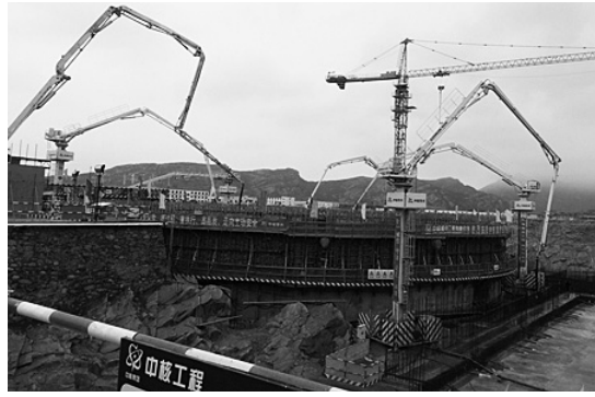
コンクリート打設は中国核電工程会社が担当
