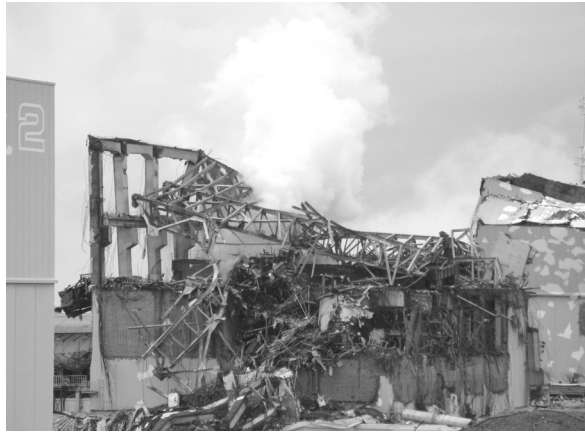
2011年3月14日午前11時頃に水素爆発を起こした福島第一3号機の原子炉建屋=3月15日撮影
