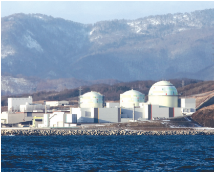
北海道電力の泊原子力発電所。右端が今回、定検入りした3号機。
