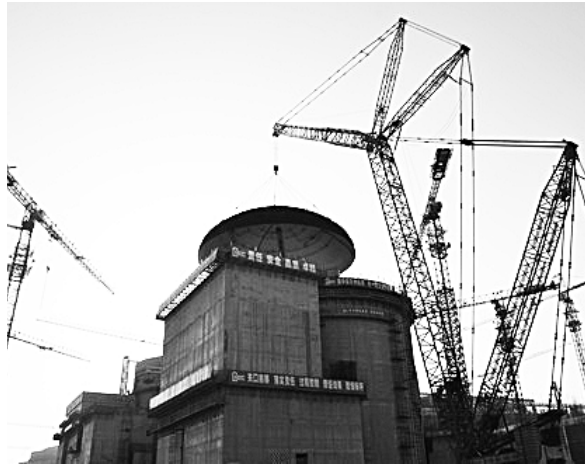
寧徳4号機のドーム型屋根設置作業 (© CNECC)
