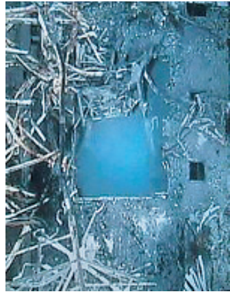
3号機燃料プールの上空からの現況写真。一部は瓦礫撤去済み。
