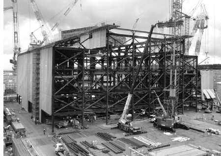
建設中の原子炉建屋(二〇年十二月) 大間発電所完成予想図
