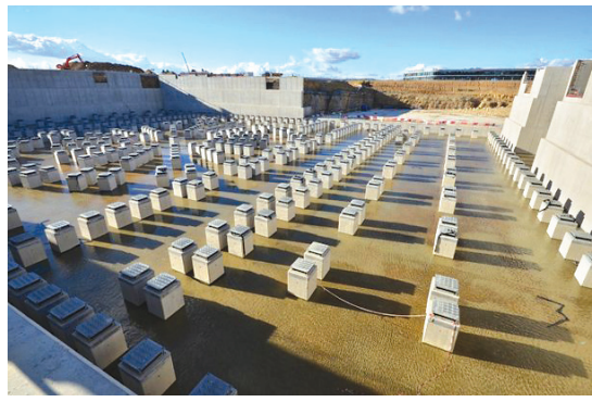
フランス南東部カダラッシュのITERサイト。トカマク本体部分など総重量36万トンを地下で支える493基の免震パットがすでにできあがっている。
