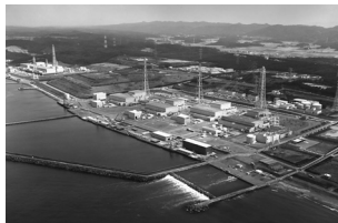
防災など安全対策を実施
