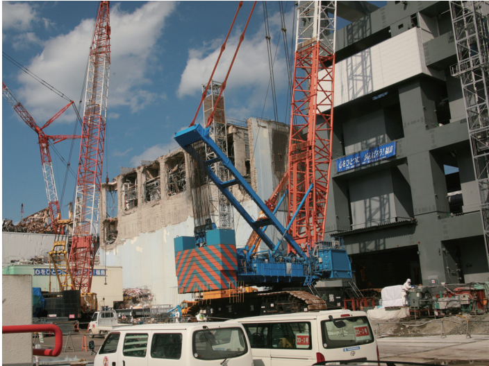
⑤4号機建屋では、今年11月の使用済み燃料プールからの燃料取り出しを目指し、カバー設置工事など、作業が進展している。
