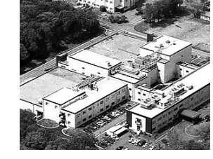
放射線利用技術による福島復興への貢献(高崎研究所で実施中のもの)
