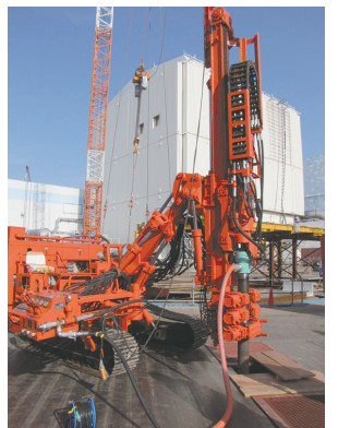
福島第一、汚染水対策の一環 凍土壁 本格着工
