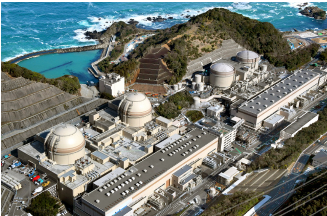
【関西電力大飯原子力発電所（福井県おおい町）】
