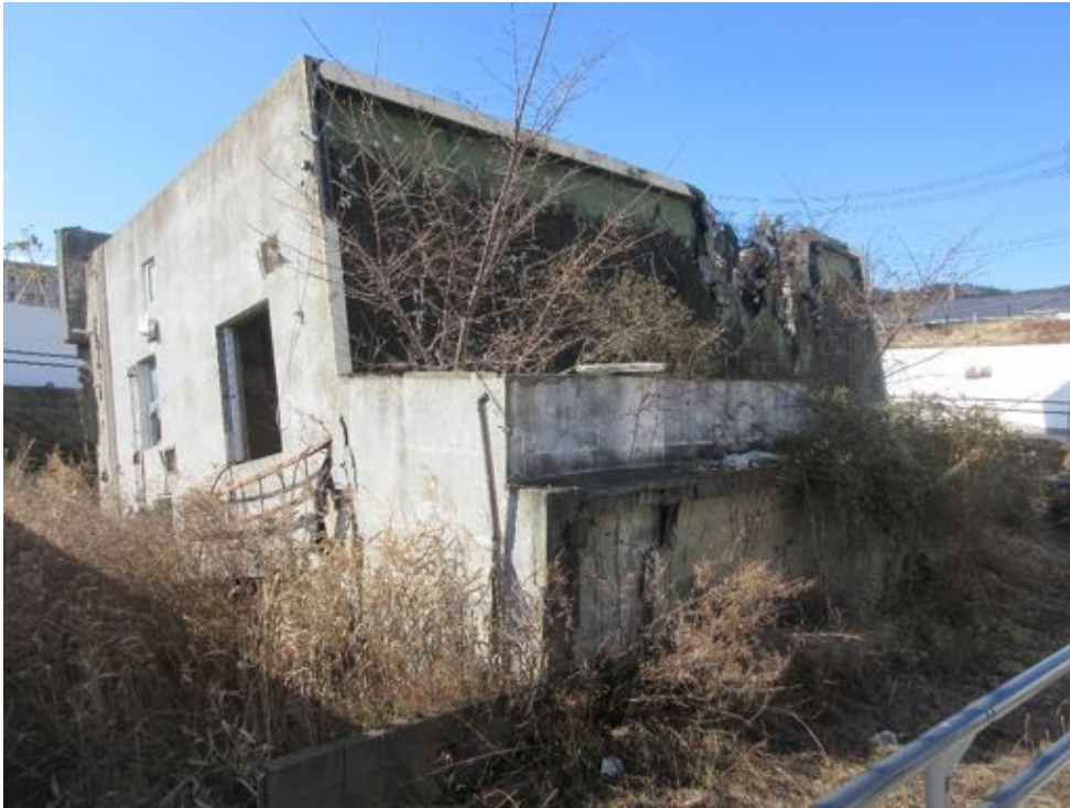
【倒れている旧女川交番（震災遺構）（女川町）】
