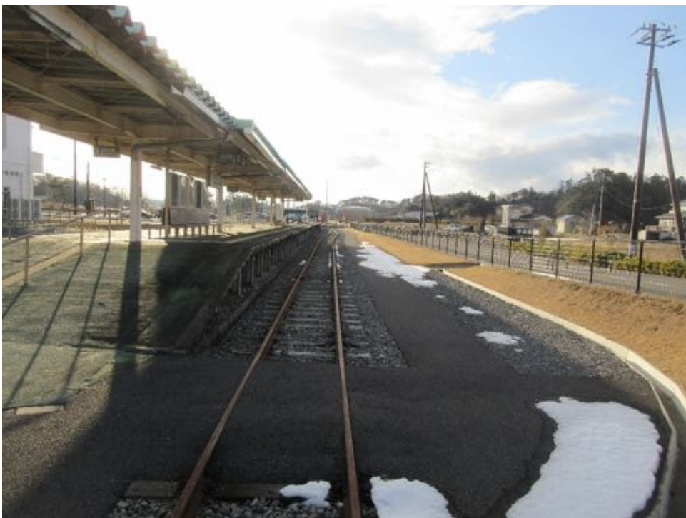
【津波で曲がった野蒜駅のレール（震災遺構）（東松島市）】
