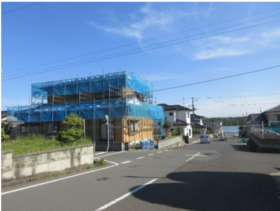
【屋根が破損し、ブルーシートで覆われた家（相馬市松川浦）】
