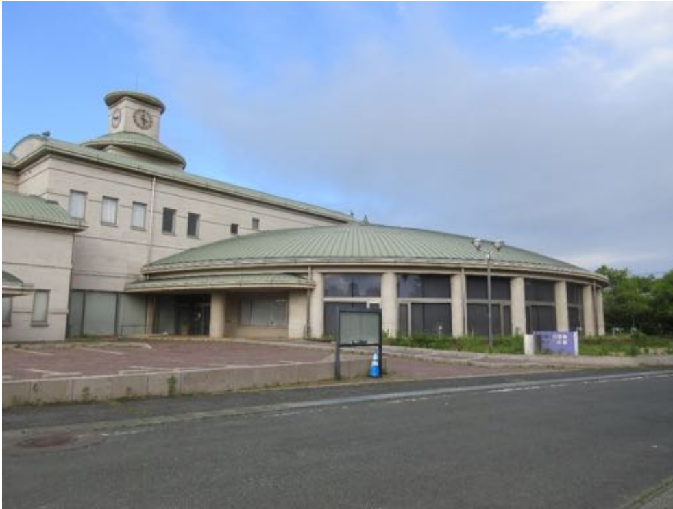
【建物の解体が決まった大熊町図書館—13万冊の蔵書があった（大熊町）】
