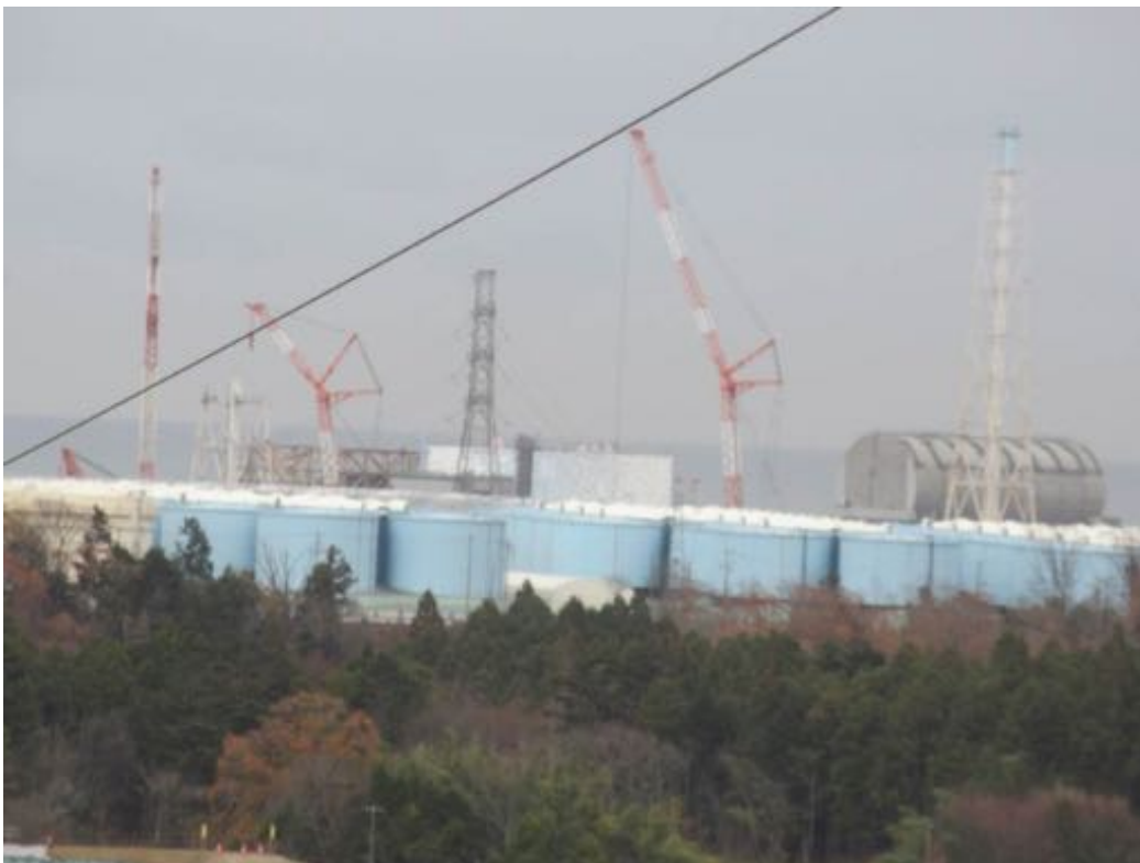
【福島第一原発 手前は放射能汚染水の貯蔵タンク（大熊町）】
