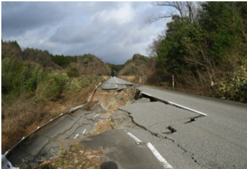
北陸電力志賀原発から直線距離で約 14 キロ北の道路は大きく陥没し、通行できなくなっていた=2024 年 1 月 5 日午後、石川県志賀町、佐々木凌撮影（「朝日新聞デジタル」2024 年 1 月 16 日 21 時 00 分）
