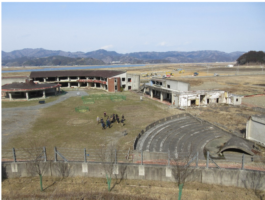
【大川小学校一直ぐ傍の小山から撮影（石巻市）】
