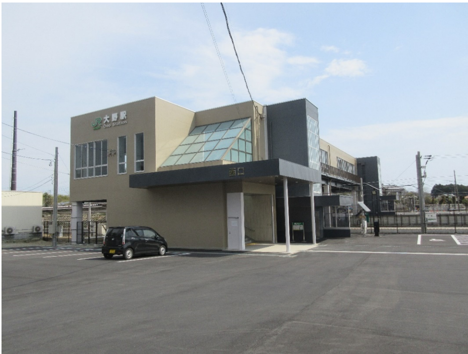
【3月14日に再開した JR 常磐線大野駅一周りの家々は柵で閉鎖（大熊町）】
